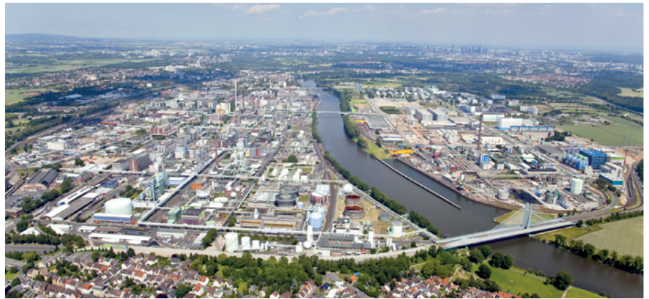
Sanofi Standort Frankfurt: Industriepark Höchst
